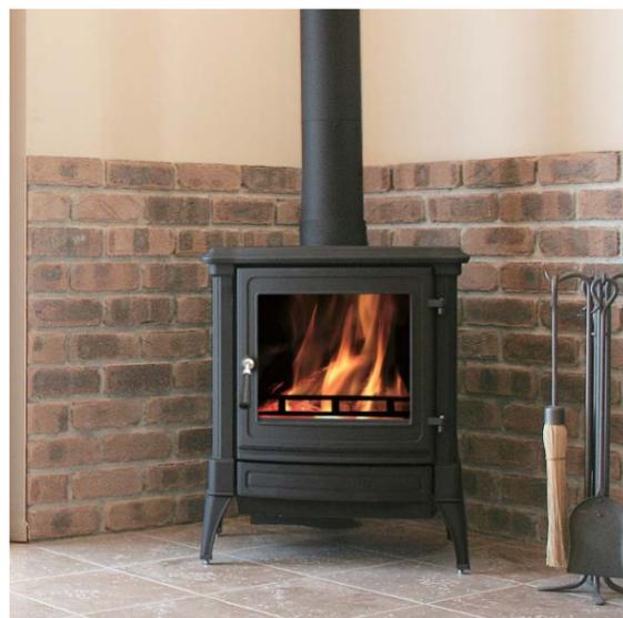
ストーブの施工に際しては、熱から壁や床を守るための熱養生が必要です。
